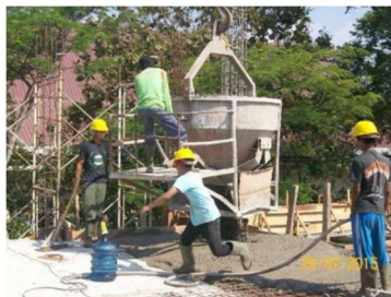
Gambar IV. 59: Contoh pembersihan area pengecoran balok dan plat
