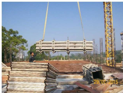
Gambar IV. 32: Contoh pengangkutan bekisting kolom dengan tower crane
