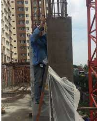
Gambar IV. 45: Contoh proses perawatan beton kolom
