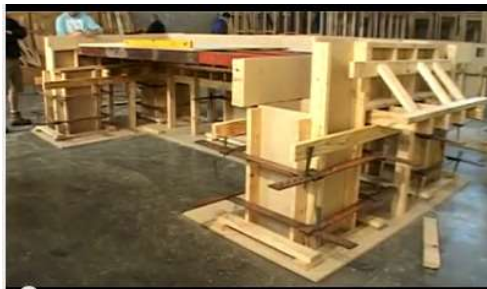
Gambar IV. 47: Contoh fabrikasi balok dan plat
