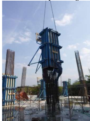
Gambar IV. 34: Contoh pengangkatan bekisting kolom dengan tower crane
