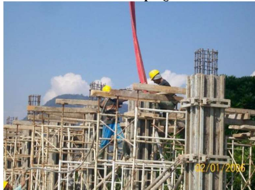
Gambar IV. 41: Contoh pematatan beton kolom dengan vibrator
