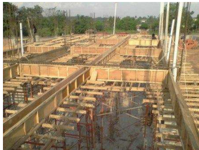
Gambar IV. 50: Contoh pemasangan bekisting balok
