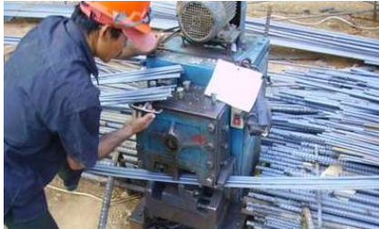
Gambar IV. 67: Contoh pemotongan besi tulangan
