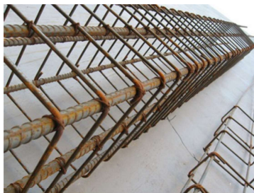
Gambar IV. 27: Contoh besi tulangan kolom yang telah dirakit
