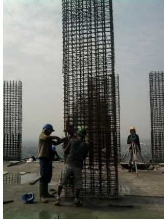
Gambar IV. 29: Contoh pemasangan tulangan kolom
