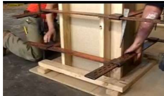
Gambar IV. 30: Contoh proses fabrikasi bekisting kolom
