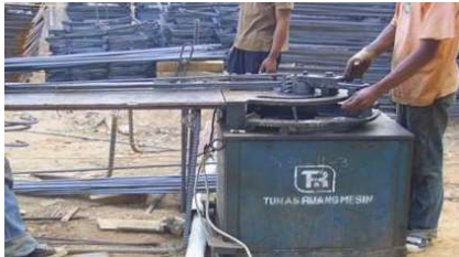
Gambar IV. 68: Contoh pembengkokan besi tulangan
