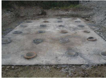
Gambar 0.1 : Contoh pembuatan lantai kerja
