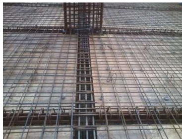
Gambar IV. 57: Contoh pemasangan tulangan balok dan plat
