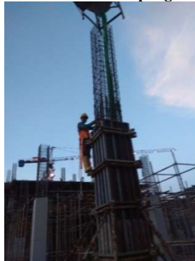
Gambar IV. 40: Contoh pengecoran kolom
