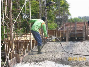
Gambar IV. 61: Contoh adonan beton yang dipadatkan dengan vibrator
