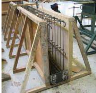
Gambar IV. 55: Contoh pemasangan tulang balok
