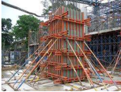
Gambar IV. 35: Contoh pemasangan bekisting kolom
