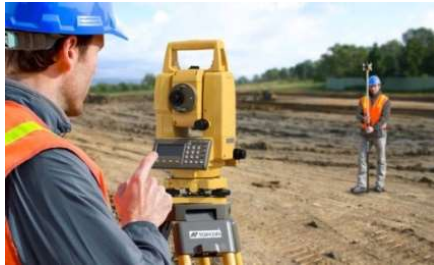
Gambar IV. 6: Contoh penggunaan theodolit pada pekerjaan marking
