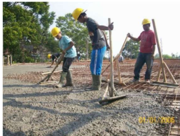
Gambar IV. 62: Contoh perataan beton dengan ruskam kayu
