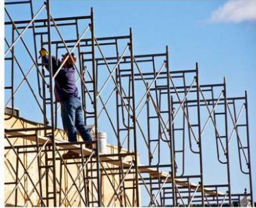
Gambar IV. 48: Contoh penyusunan scaffolding
