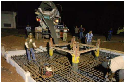
Gambar IV. 13: Contoh pekerjaan pengecoran base tower crane
