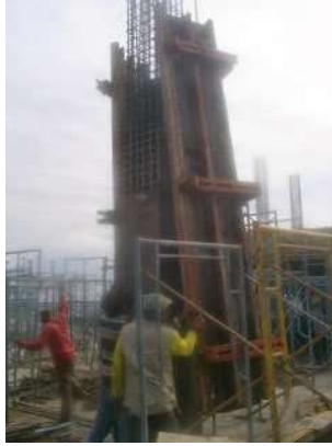
Gambar IV. 42: Contoh pengerjaan pembongkaran bekisting kolom
