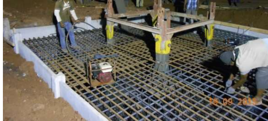
Gambar IV. 12: Contoh pengerjaan pembesian tower crane
