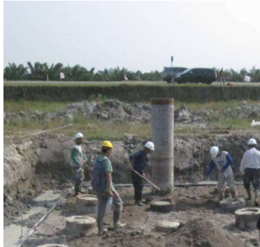
Gambar IV. 9: Contoh proses pemotongan kepala tiang pancang
