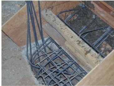
Gambar IV. 71: Contoh beton ditunangkan ke area pondasi tangga
