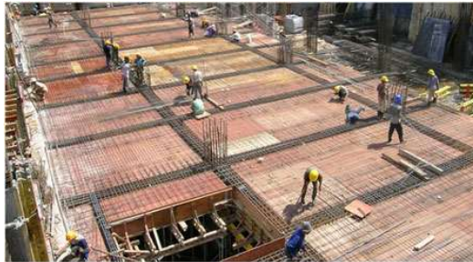
Gambar IV. 56: Contoh pemasangan tulangan plat
