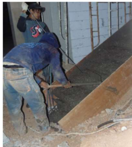
Gambar IV. 72: Contoh beton disebarkan dari atas tangga ke bawah
