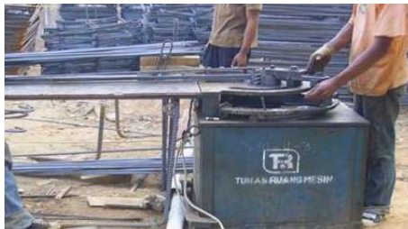
Gambar IV. 26: Contoh pembengkokan besi tulangan
