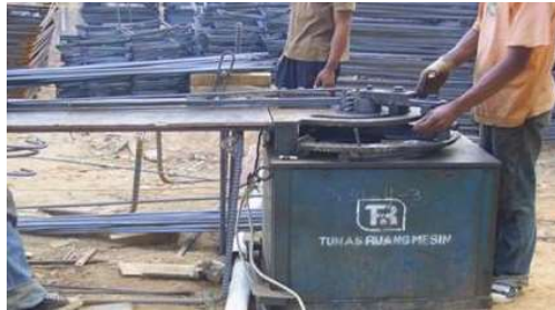
Gambar IV. 53: Contoh pembengkokan besi tulangan
