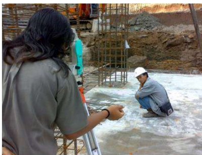
Gambar IV. 23: Contoh pekerjaan marking kolom
