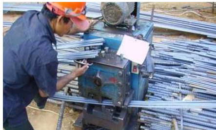
Gambar IV. 25: Contoh pemotongan besi tulangan
