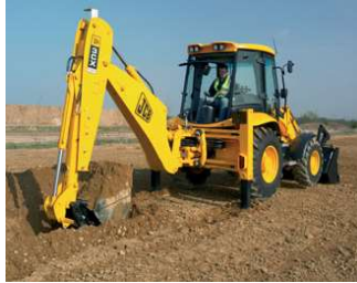
Gambar IV. 8: Contoh penggalian tanah pondasi dengan eskavator
