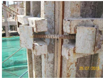
Gambar IV. 36: Contoh pemasangan clemp
