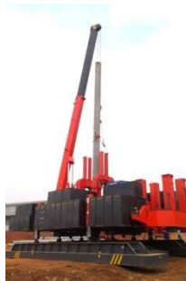
Gambar IV. 7: Contoh proses pemancangan dengan HSPD ( Hydraulic Static Pile Driver )
