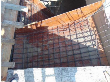
Gambar IV. 66: Contoh kemiringan plywood pada bekisting
