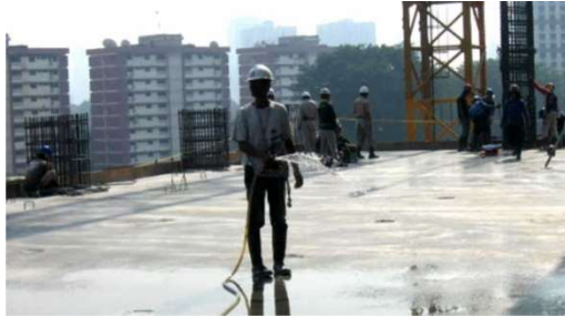
Gambar IV. 63: Contoh perawatan balok plat
