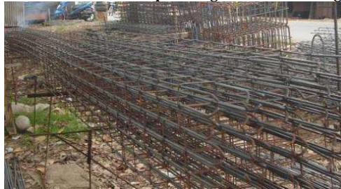
Gambar IV. 54: Contoh tulangan balok yang telah dirakit
