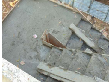
Gambar IV. 73: Contoh pembongkaran plat tangga
