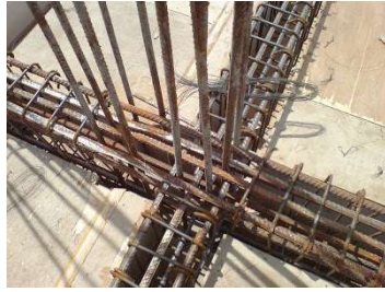
Gambar IV. 58: Contoh pemasangan tulangan balok
