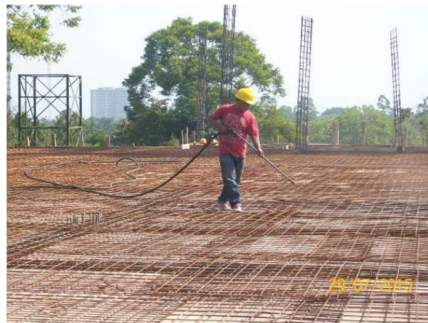
Gambar IV. 59: Contoh pembersihan area pengecoran balok dan plat
