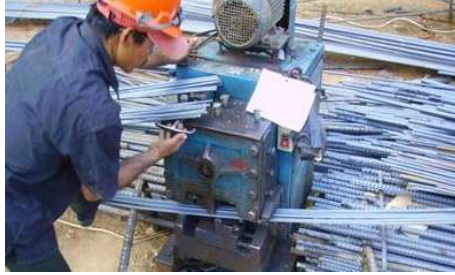
Gambar IV. 52: Contoh pemotongan besi tulangan
