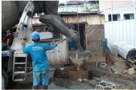
Gambar 2. 7 Pekerjaan pengecoran (Sumber: http://duniatekniksipil76.blogspot.com )
