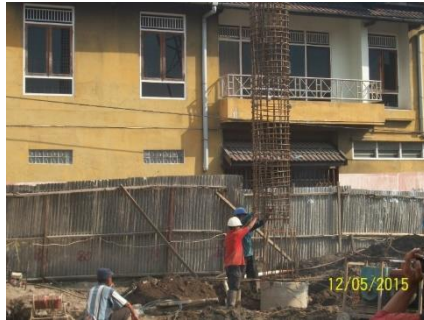
Gambar 2. 5 Penurunan tulangan besi yang sudah difabrikasi kedalam lubang bor (Sumber: http://duniatekniksipil76.blogspot.com )
