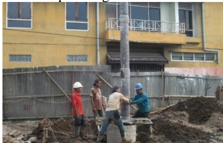
Gambar 2. 6 Setting pipa tremi persiapan pengecoran (Sumber: http://duniatekniksipil76.blogspot.com )
