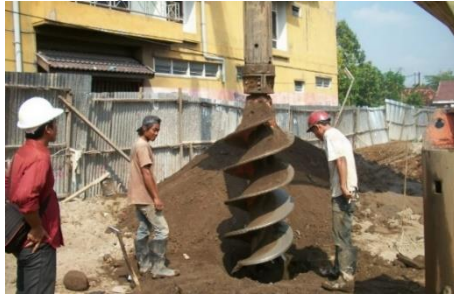
Gambar 2. 2 Pengeboran titik bore pile dengan mata bor auger (Sumber: http://duniatekniksipil76.blogspot.com )
