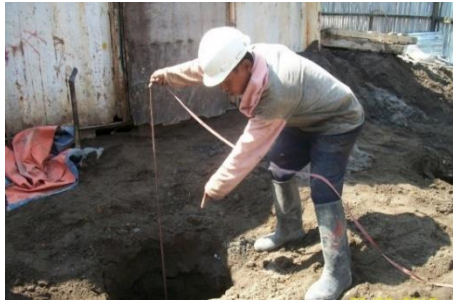
Gambar 2. 4 Pengecekan kedalaman lubang dengan meteran (Sumber: http://duniatekniksipil76.blogspot.com )
