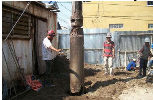
Gambar 2. 3 Pembersihan lubang bor dengan cleaning bucket
