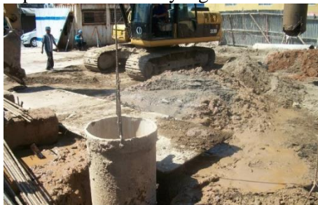
Gambar 2. 1 Pemasangan Casing Temporary (Sumber: http://duniatekniksipil76.blogspot.com )
