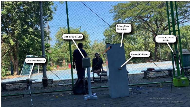
Gambar 4.24 Kendaraan Telah Lewat dan Palang Pintu Kembali Tertutup.
