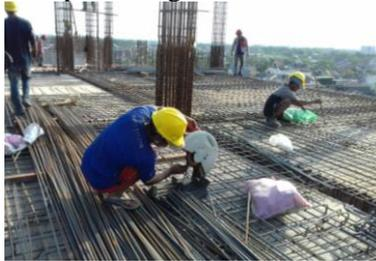
Gambar 5. 17 Pekerjaan Penulangan Plat
