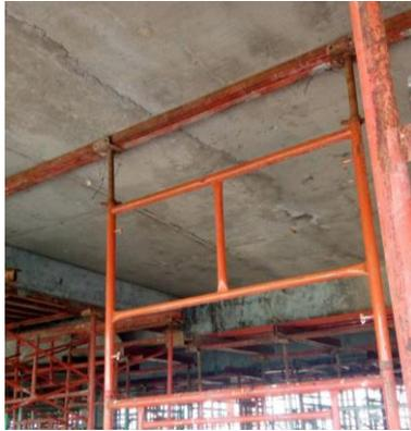
Gambar 5. 19 Pekerjaan Shoring Plat dan Balok
