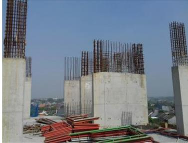
Gambar 5. 13 Kolom yang Telah Dibongkar Bekisting
