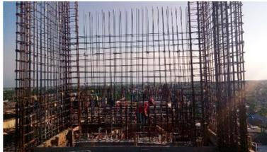
Gambar 5. 21 Penulangan *Shear Wall*
