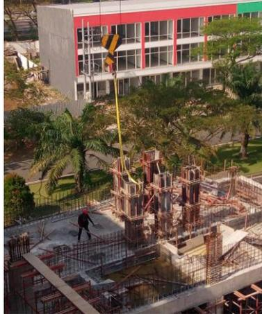
Gambar 5. 9 Pengangkatan Bekisting Kolom
