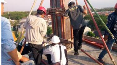
Gambar 5. 11 Pemasangan Penyangga Bekisting
