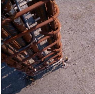
Gambar 5. 22 Sepatu Kolom pada *Shear Wall*
