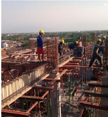
Gambar 5. 15 Pekerjaan Penulangan Balok
