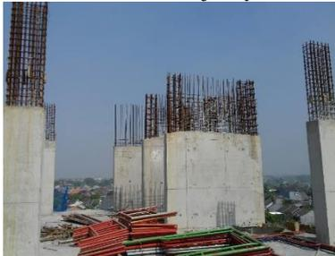
Gambar 5. 23 Tampak Struktur *Shear Wall*
