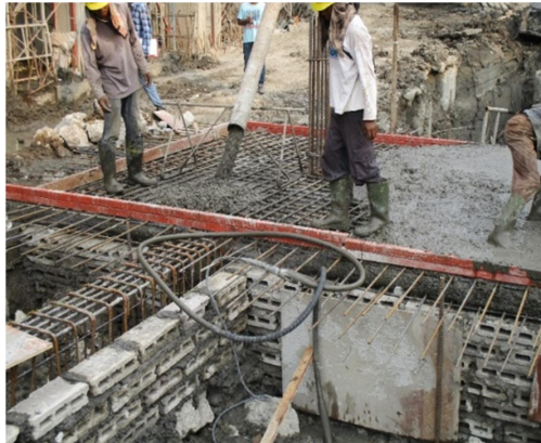
Gambar 8. Proses Pekerjaan Pengecoran PileCap Sumber : Pribadi, Proyek Puri City Surabaya, 2018
