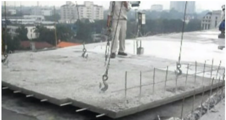
Gambar 13. Proses Pengangkatan Beton
