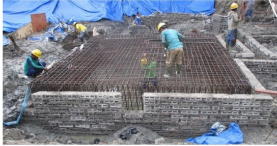
Gambar 7. Pemasangan Tulangan PileCap Sumber: Pribadi. Proyek Puri City Surabaya, 2018
