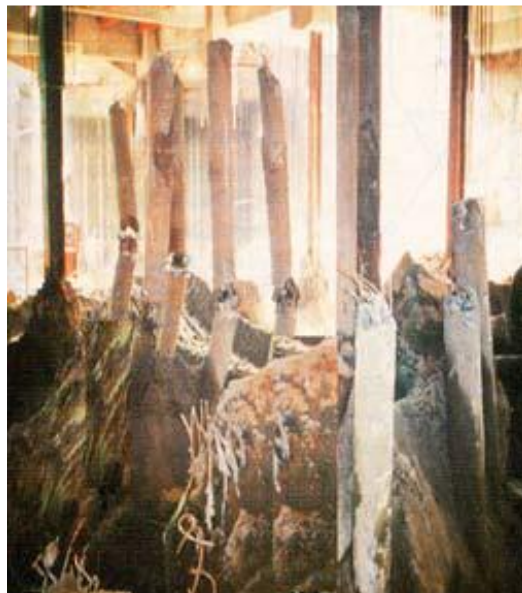
(b) Plastifikasi tiang pancang di dalam tanah
