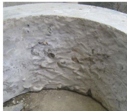
(d) Tonjolan agregat dinding spun pile
