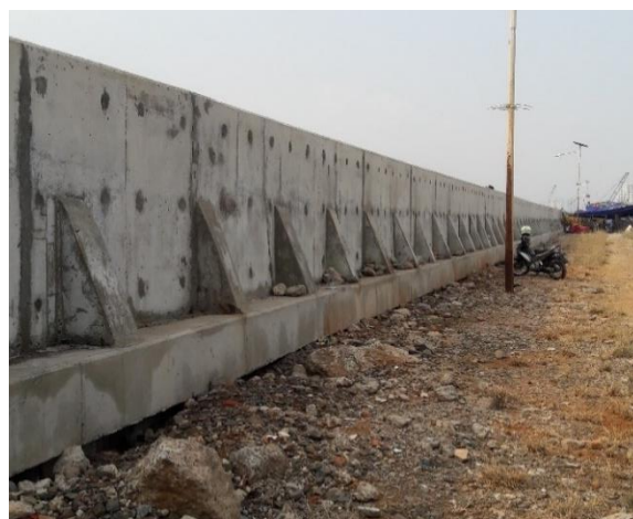
Gambar 4.24 penambahan tinggi seawall di Kawasan pelabuhan muara baru
