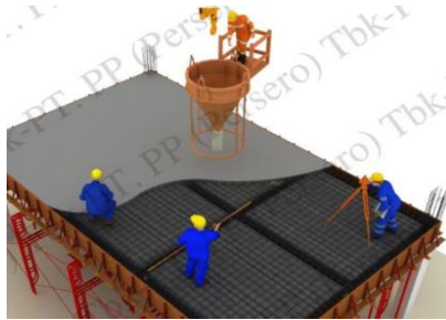
Gambar 4.22 Sketsa bekisting plat tampak atas
