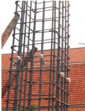
Gambar 4.33 Pemasangan Beton decking kolom
