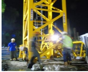
Sumber : PT. Brantas Abipraya Gambar 4.18 Pemasangan mast section
