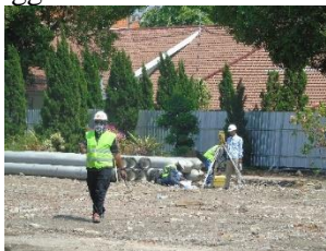
Gambar 4.11 Pekerjaan marking menggunakan theodolite
