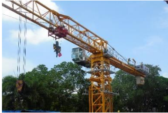
Sumber : PT. Brantas Abipraya Gambar 4.23 Pengangkatan kabin tower crane
