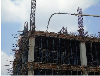
Sumber : PT. Brantas Abipraya Gambar 4.51 pengecoran balok dan plat
