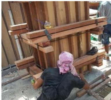
Gambar 4.34 Pemasangan Beton decking kolom
