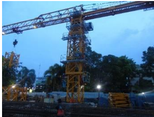
Sumber : PT. Brantas Abipraya Gambar 4.24 Pengangkatan mast section
