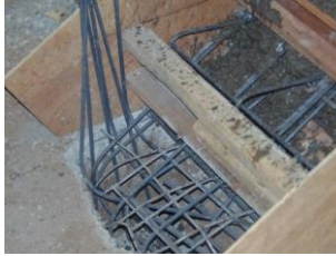
Sumber : PT. Brantas Abipraya Gambar 4.54 Contoh beton ditunagkan ke area pondasi tangga
