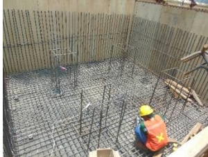
Gambar 4 15 Pekerjaan pemasangan tulangan footplate tower crane
