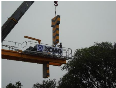
Gambar 4.22 Pemasangan counter weight
