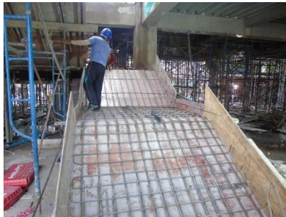
Gambar 4.52 Contoh marking anak tangga
