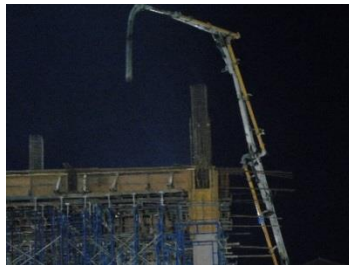
Gambar 4.39 Pengecoran kolom menggunakan concrete pump
