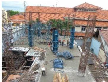
Gambar 4.35 Pemasangan bekisting kolom
