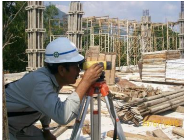
Gambar 4.50 Contoh pengecekan ketebalan dan elevasi plat
