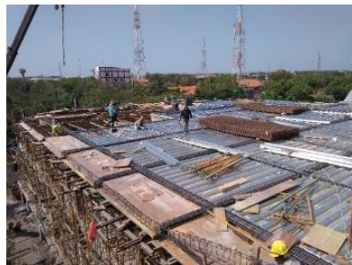
Sumber : PT. Brantas Abipraya Gambar 4.49 pemasangan tulangan balok dan plat
