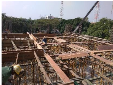
Sumber : PT. Brantas Abipraya Gambar 4.46 Pembuatan bekisting balok
