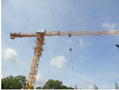
Sumber : PT. Brantas Abipraya Gambar 4.26 Tower crane yang sudah terpasang
