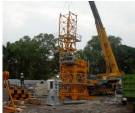
Sumber : PT. Brantas Abipraya Gambar 4.19 Pemasangan mast section
