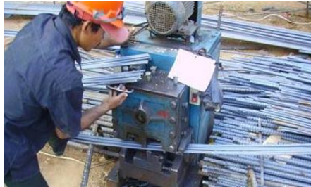
Gambar 4.29 Pemotongan tulangan pada fabrikasi
