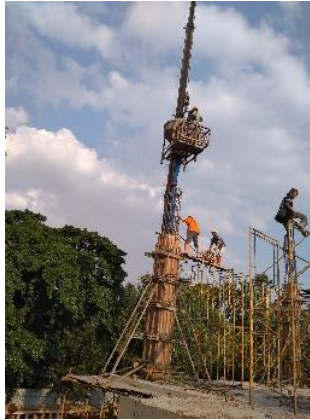
Gambar 4.38 Pengecoran kolom menggunakan bucket cor
