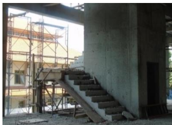
Gambar 4.56 Contoh pembongkaran plat tangga
