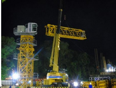
Gambar 4.21 Pemasangan boom dan counter jib
