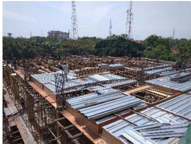
Sumber : PT. Brantas Abipraya Gambar 4 47 pekerjaan pemasangan bondek
