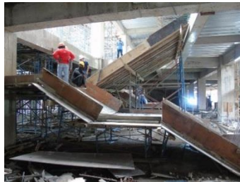
Gambar 4.53 Contoh kemiringan plywood pada bekisting
