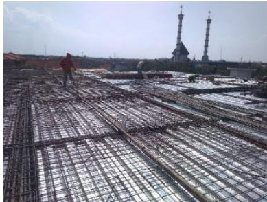
Sumber : PT. Brantas Abipraya Gambar 4.48 pemasangan tulangan plat
