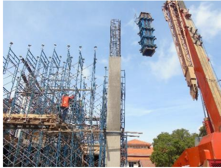
Sumber : PT. Brantas Abipraya Gambar 4.40 Pembongkaran bekisting kolom
