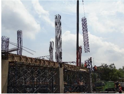
Gambar 4.31 Pengangkatan dan pemasangan tulangan kolom menggunakan mobile crane
