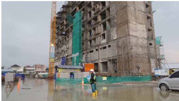
Gambar 4. 9 Proses Pembangunan Gedung Dormitory Universitas Airlangga
