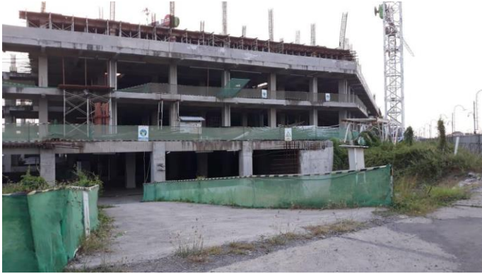
Gambar 4. 6 Proses Pembangunan Apartemen PuriCity Rungkut
