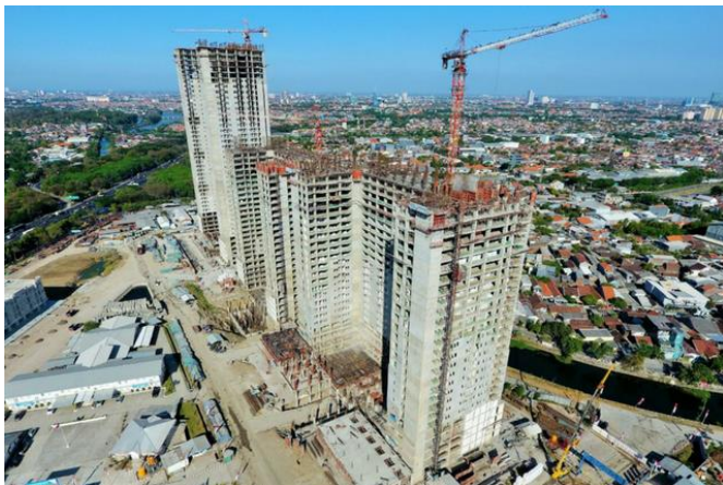
Gambar 4. 3 Proses Pembangunan Apartemen Puncak CBD Wiyung
