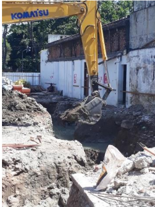
Gambar 2. 3 Galian Tanah untuk Pekerjaan Pile Cap
