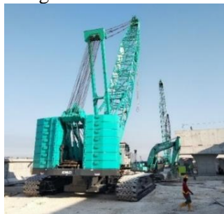
Gambar 2. 15 Crawler Crane Sumber: Dokumentasi pribadi
