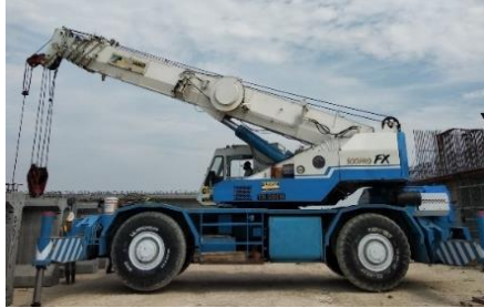
Gambar 2. 14 Mobile Crane Tadano TR500M Sumber: Dokumentasi pribadi
