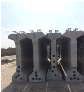
Gambar 2. 1 I Girder Sumber: Dokumentasi pribadi
