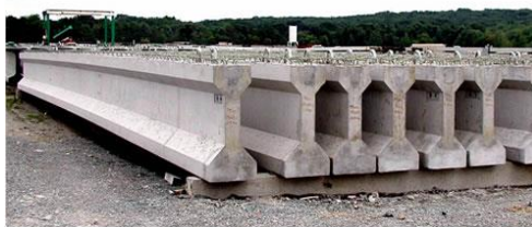
Gambar 2. 24 PCI Girder Sumber: Dokumentasi proyek
