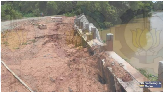
Gambar 2. 8 Konstruksi Turap dengan Material Beton (Sumber : sarolangunonline.com)
