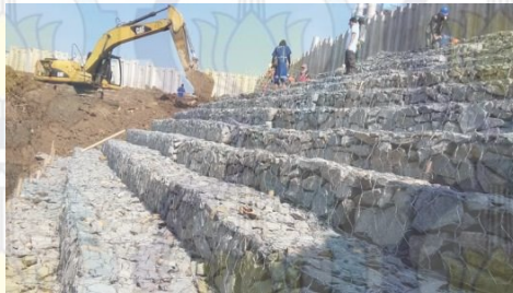
Gambar 2. 7 Pemasangan bronjong (Sumber: penjualkawatbronjong.wordpress.com )
