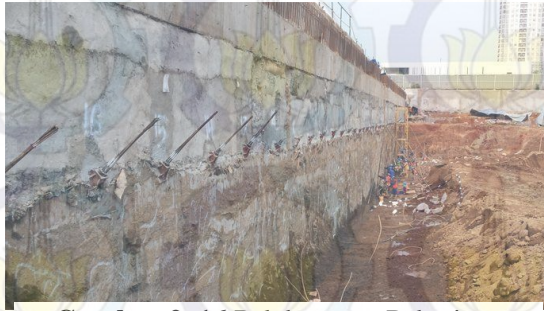
Gambar 2.16 Pelaksanaan Pekerjaan Ground Anchor (Sumber: Indopora.com)
