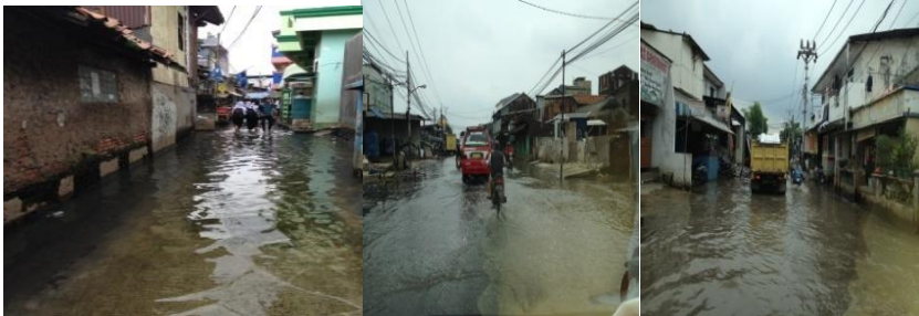
Gambar 4.4 Keadaan Lokasi Banjir di Permukiman Kumuh Berat Kelurahan Kapuk
