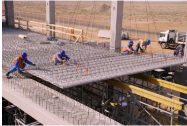
Gambar 2. 6 Contoh Pemasangan Plat Precast
