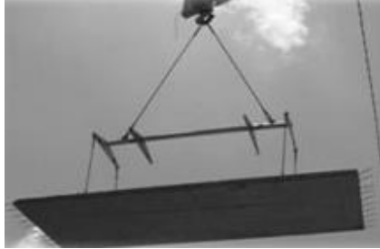
Gambar 2. 5 Contoh Pengangkatan Plat Precast
