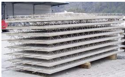
Gambar 2. 4 Contoh Penumpukan Plat Precast
