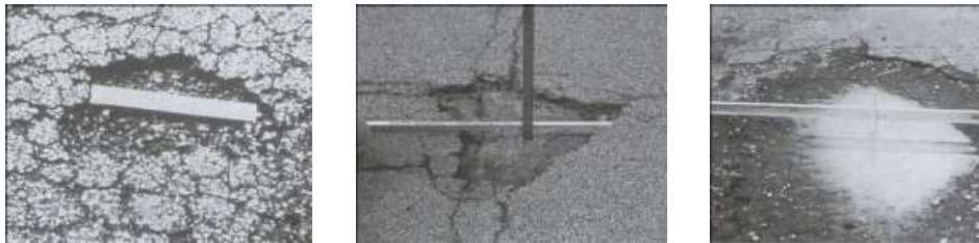
Gambar 2.4 Contoh lubang pada perkerasan lentur.
