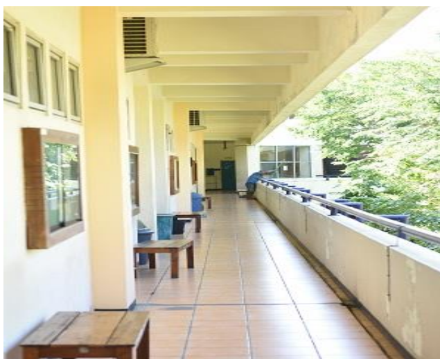
Gambar 5.2 Lokasi Uji Coba
