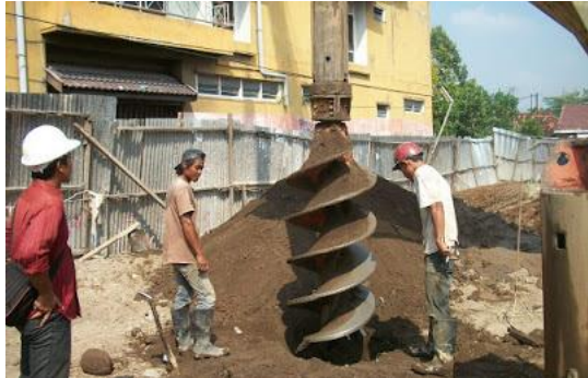
Gambar 2.4 Pengeboran titik bored pile dengan maa bor auger
