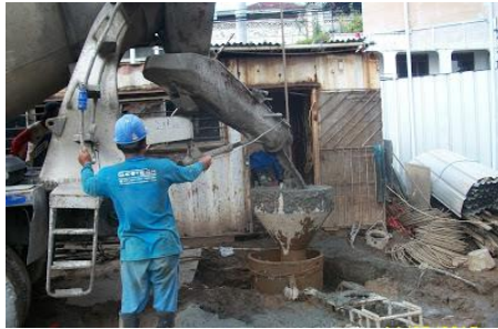
Gambar 2.6 Pengecoran menggunakan pipa tremi
