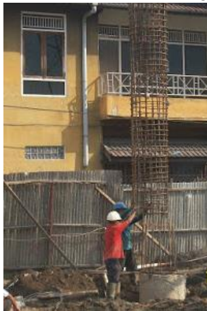
Gambar 2.5 Penurunan tulangan besi yang sudah dipabrikasi ke dalam lubang bor
