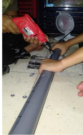
Proses melubangi pada pipa
