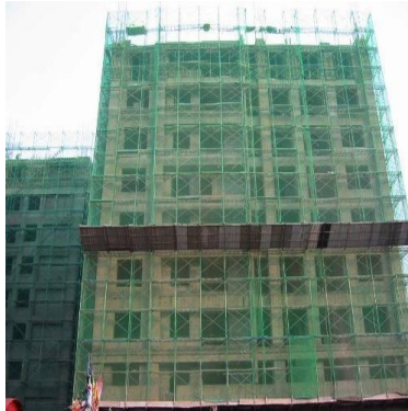
Gambar 5.19 : Sistem jaring keselamatan horizontal. Sumber : indiamart.com
