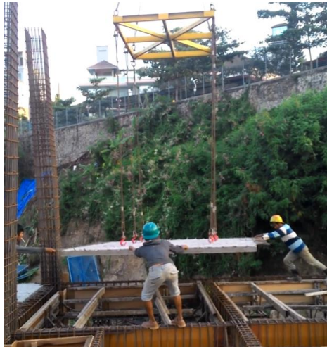
Gambar 5.2 : Pemasangan pelat pracetak.
