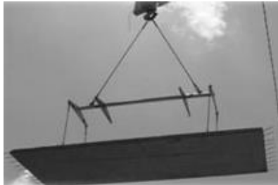
Gambar 5.1 : Contoh pengangkatan plat pracetak dengan 4 titik.
