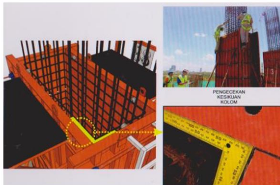
Gambar 5.3 : Pengukuran kesikuan pada bekisting.
