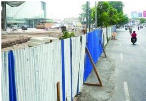
Gambar 5.20 : Pemagaran proyek. Sumber : metodebangunan.blogspot.com
