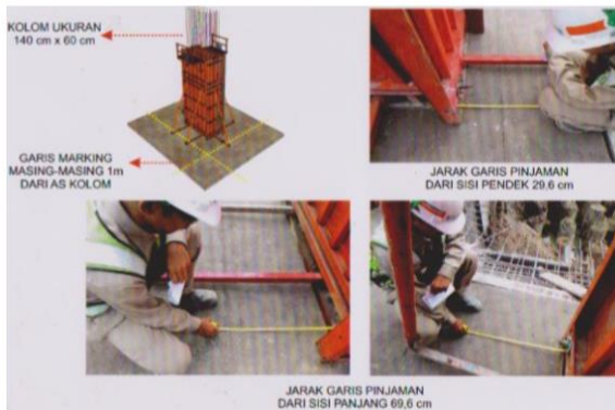
Gambar 5.4 : Pengukuran jarak garis pinjaman as kolom.
