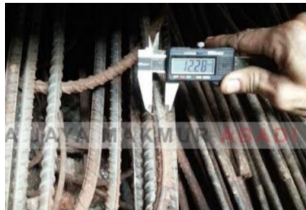
Gambar 5.7 : Uji diameter fisik.
