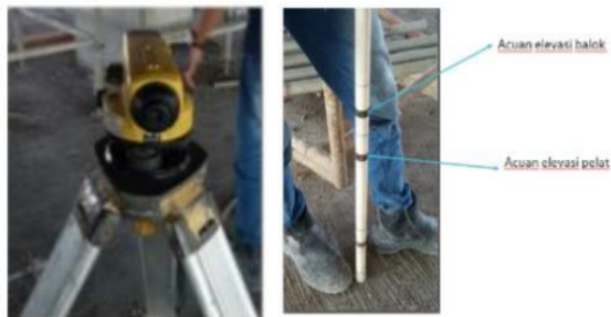
Gambar 5.6 : Pengukuran untuk elevasi bekisting.
