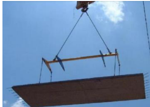
Gambar 6.1 : Pengangkatan pelat halfslab precast . Sumber : PT. PP (persero),Metode pecast half slab, Jakarta.
