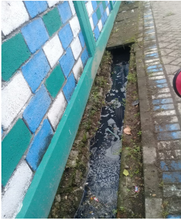
Gambar L5. 4 Drainase Tidak Dipelihara di RT 27
