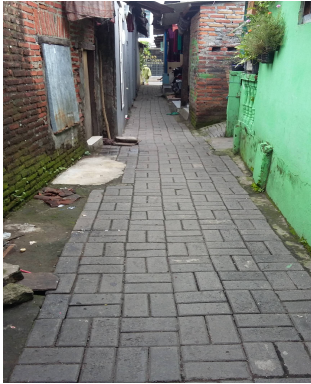
Gambar L5. 10 Jalan Lingkungan Berpaving RT 07
