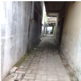
Gambar L5. 8 Jalan Lingkungan Tidak Memadai di RT 29
