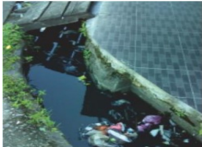
Gambar 2. 11 Kondisi Saluran Drainase yang Tidak Terpelihara
