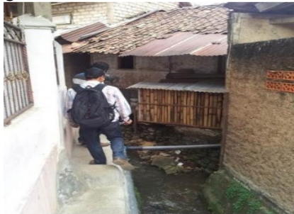
Gambar 2. 3 Kondisi Ketidakteraturan Bangunan (Menteri Pekerjaan Umum dan Perumahan Rakyat Republik Indonesia 2016)
