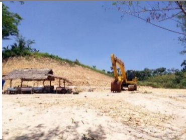
Proses pembangunan, pelebaran pesisir
