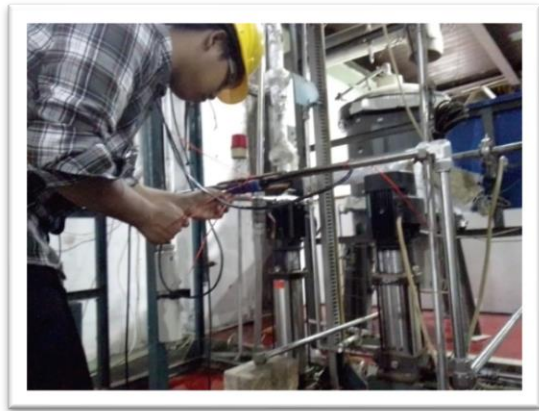
Gambar 8. Pemasangan Ultrasonic Flowmeter pada Untai Uji Beta
