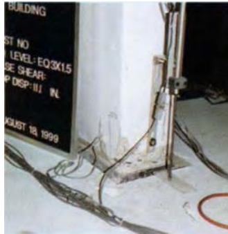
Gambar 2. 6 Minor Spalling pada Dasar Dinding Geser (Sumber: Priestley dkk, 1999)
