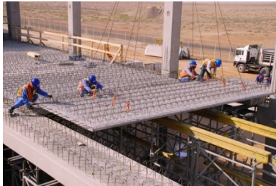
Gambar 6. 3 Contoh Pemasangan Plat Precast
