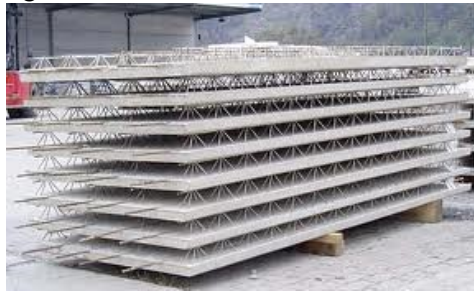
Gambar 6. 1 Contoh Penumpukan Plat Precast
