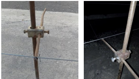
Gambar 4.29 Kabel Patok Sensor dan String Line
