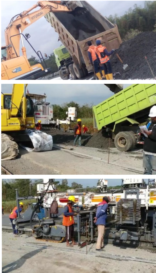
Gambar 4.33 Proses Penuangan Beton Kelas P
