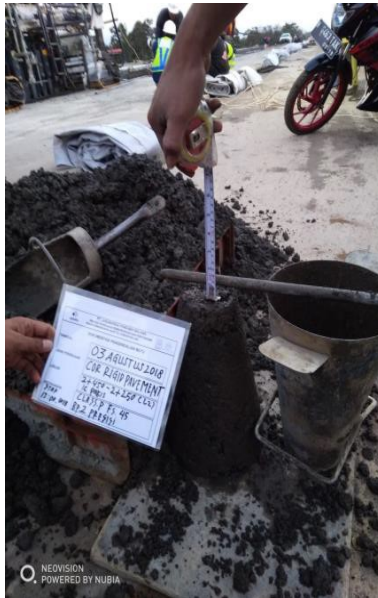
Gambar 4.32 Uji Slump Beton Kelas P
