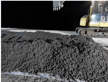
Gambar 4.31 Beton Datang Dari Batching Plan
