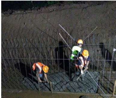
Gambar 4.14 Pembesian RCP Type B
