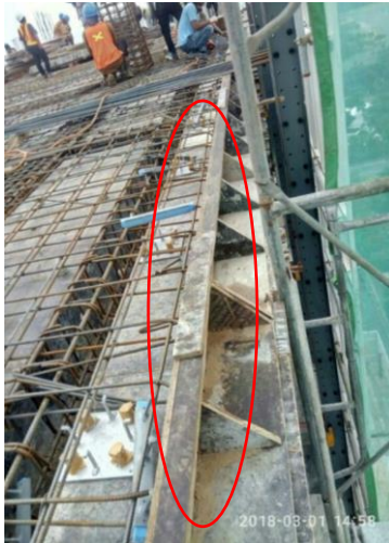
Gambar 4.44 Pemasangan Bekisting Perimeter
