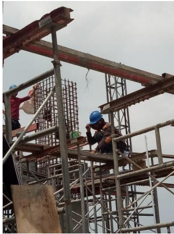
Gambar 4.42 Proses Pemasangan Gelagar dan Suri-suri
