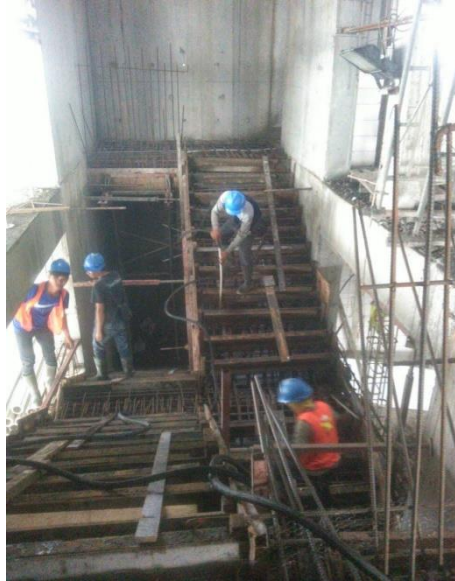
Gambar 4.67 Proses Pengecoran dan Pemasangan Bekisting Tangga
