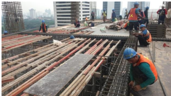
Gambar 4.41 Hasil Pemasangan Gelagar dan Suri-suri
