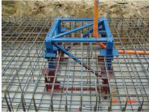
Gambar 4.10 Pemasangan Pondasi Tower Crane Sebelum di Cor
