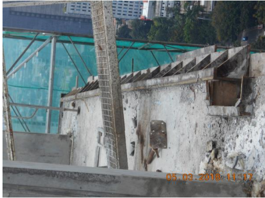
Gambar 4.59 Pembongkaran Bekisting Perimeter
