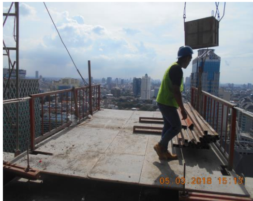
Gambar 4.62 Perletakan Material Di Terminal Barang
