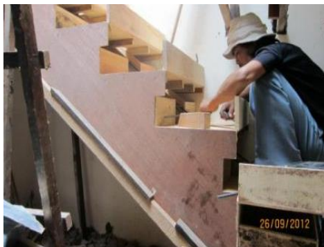
Gambar 4.63 Pekerjaan Bekisting Tangga
