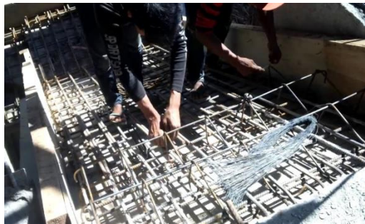
Gambar 4.65 Pekerjaan Perakitan Tulangan Tangga
