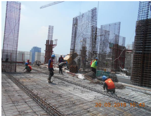
Gambar 4.47 Proses Perakitan Tulangan Balok
