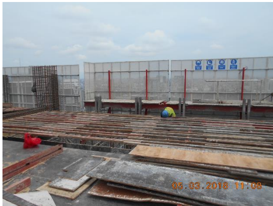
Gambar 2.4 Mengganti Safet Net dengan Facade Protector pada Facade Gedung
