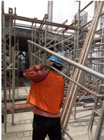
Gambar 4.61 Pembongkaran Main frame dan Cross brace
