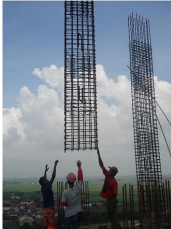
Gambar 4.25 Gambar Pemasangan Tulangan Kolom
