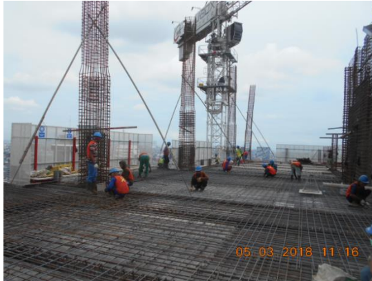
Gambar 4.26 Pemasangan Penyangga Tulangan Kolom
