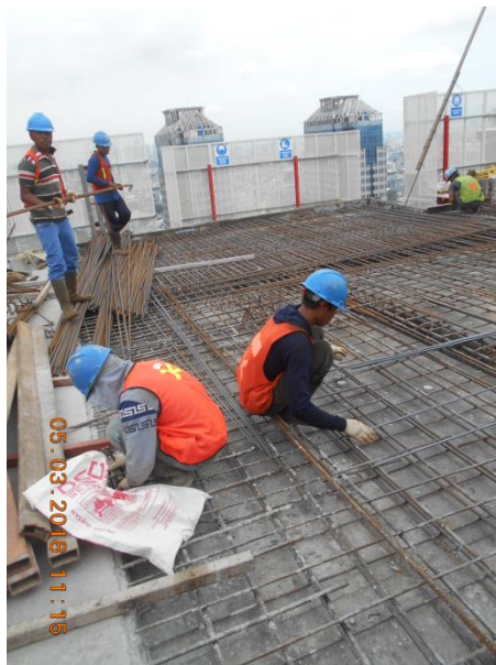
Gambar 4.50 Pekerjaan Pemasangan Tulangan Pelat
