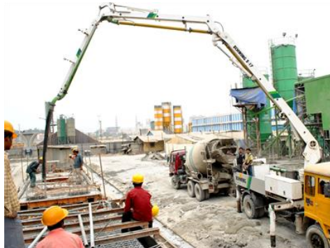
Gambar 4.53 Pekerjaan Pengecoran dengan Concrete Pump
