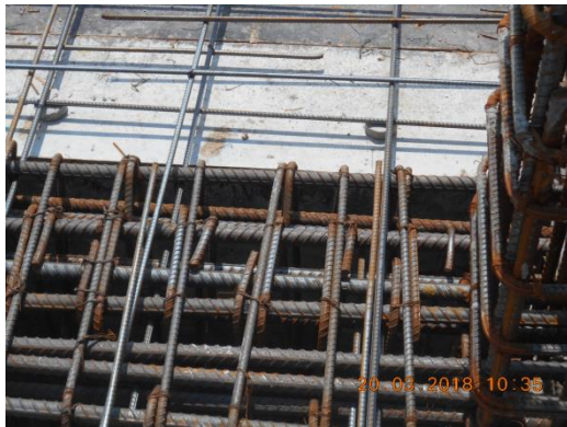
Gambar 4.48 Tulangan Balok yang Telah Dirakit dan Diberi Beton Decking
