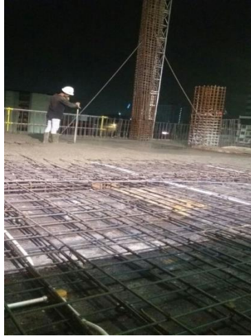
Gambar 4.55 Pemasangan dan Pemasangan dengan Vibrator
