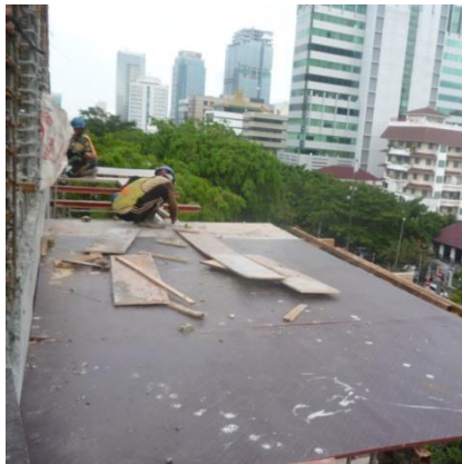
Gambar 4.43 Pemasangan Plywood Bekisting
