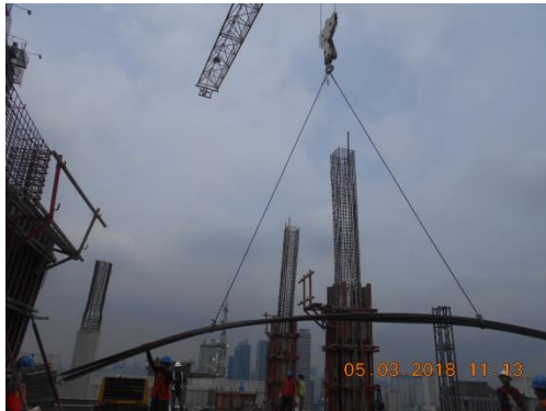
Gambar 4.49 Pekerjaan Pengangkatan Tulangan
