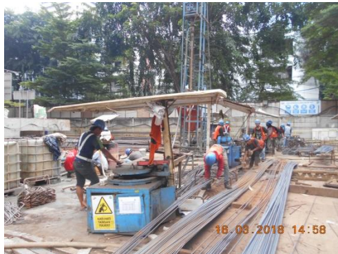
Gambar 4.21 Pemotongan dan Pembengkokan Besi di Los Besi
