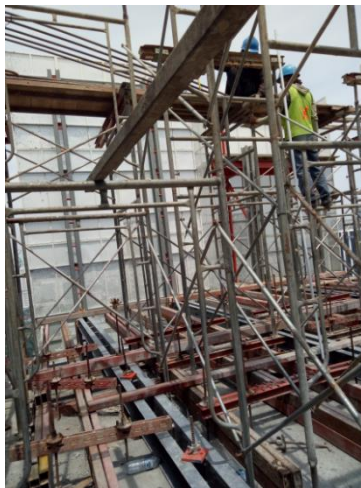
Gambar 4.60 Pembongkaran Gelagar dan Suri-suri
