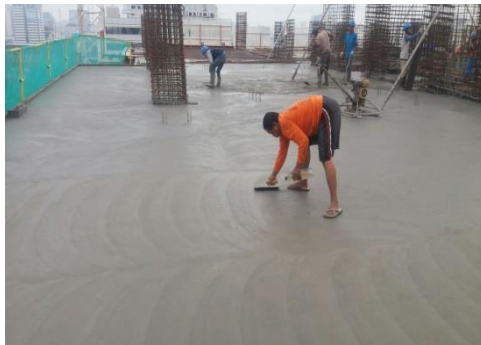
Gambar 4.57 Perataan dengan Garu Perata
