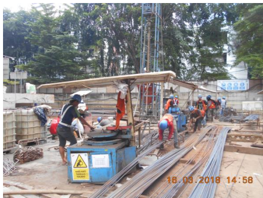
Gambar 4.64 Pemotongan dan Pembengkokan Tulangan di Los Besi
