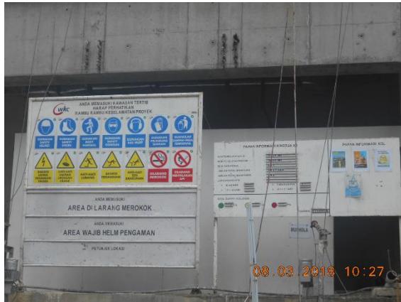
Gambar 2.7 Pemasangan Rambu-rambu K3
