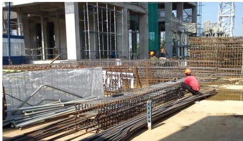
Gambar 4.23 Perakitan Tulangan Kolom
