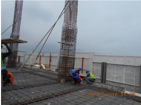
Gambar 4.51 Pekerjaan Pemasangan Tulangan dan Beton Decking Tulangan Pelat
