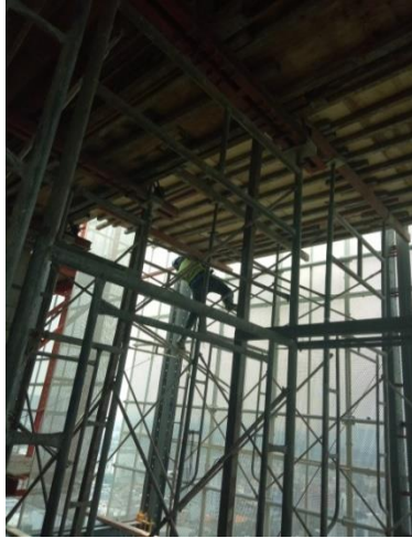
Gambar 4.45 Bekisting Pelat Lantai yang Terpasang
