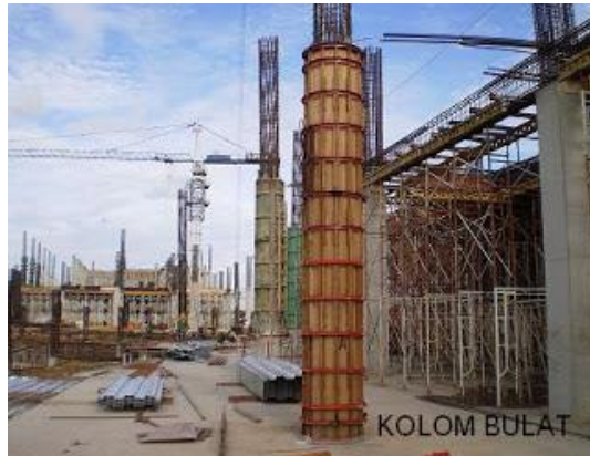
Gambar 4.27 Bekisting Kolom yang Telah Terpasang
