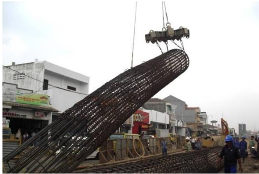
Gambar 4.24 Proses Pengangkatan Tulangan dengan Tower Crane
