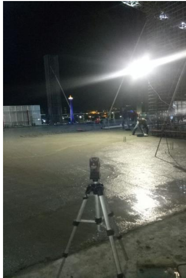
Gambar 4.58 Pengukuran Elevasi dengan Autolevel
