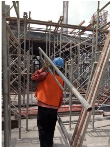
Gambar 4.40 Pekerjaan Penyusunan Scaffolding Pelat Lantai
