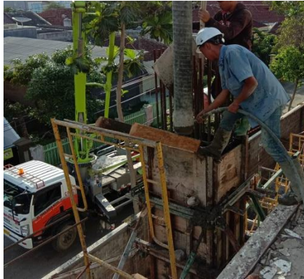
Gambar 4.32 Proses Pemadatan dengan Concrete Vibrator
