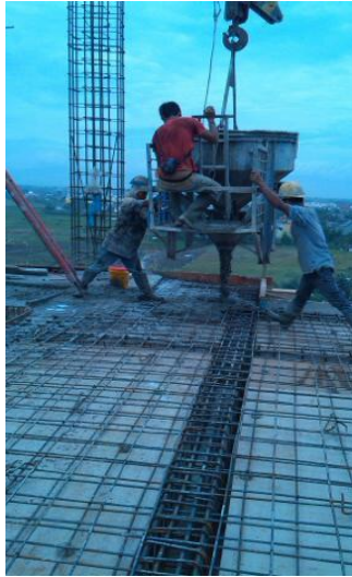
Gambar 4.54 Pekerjaan Pengecoran dengan Bucket
