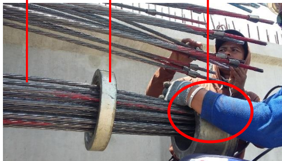
Gambar 4. 74 Pemasangan Pendorong
