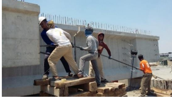
Sumber: Dokumen Pribadi Gambar 4. 66 Proses Install Strand
