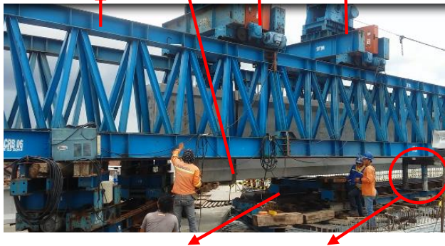
Gambar 4. 97 Pemasangan Sling Pada Hoist
