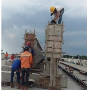
Gambar 4. 87 Penuangan Material Patching ke dalam Cetakan Bekisting
