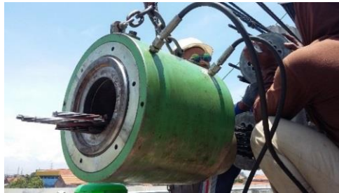
Gambar 4. 75 Pemasangan Stressing Jack
