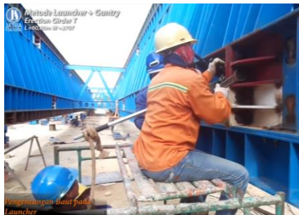
Gambar 4. 36 Pengerutan Baut Pada Launcher
