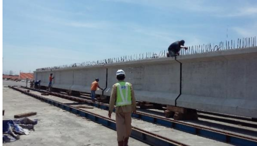
Gambar 4. 81 Proses Pengeleman
