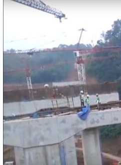
Gambar 4. 41 Pemasangan Rel Geser Menggunakan Tower Crane
