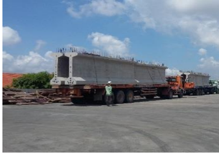
Sumber: Dokumen Pribadi Gambar 4. 44 Distribusi Girder
