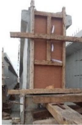
Gambar 4. 86 Pemasangan Bekisting
