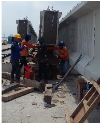
Gambar 4. 88 Pembongkaran Bekisting Patching
