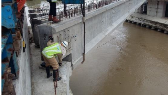
Gambar 4. 102 Kontrol Jarak pada Bearing Pad
