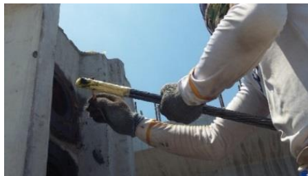
Gambar 4. 65 Pemberian Solasi dan Stempet Sebagai Pelicin Install Strand
