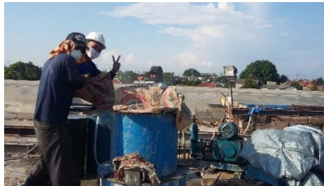
Gambar 4. 89 Pengadukan Bahan Grouting
