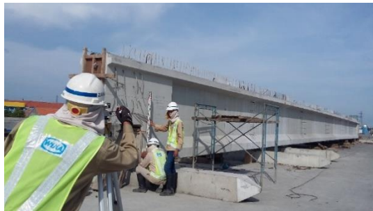
Sumber: Dokumen Pribadi Gambar 4. 84 Kontrol Chamber
