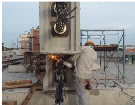
Gambar 4. 85 Pemotongan Strand
