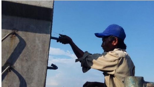
Gambar 4. 90 Kunci Selang Grouting dengan Bendrat
