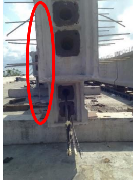
Gambar 4. 59 Levelling Girder menggunakan unting-unting
