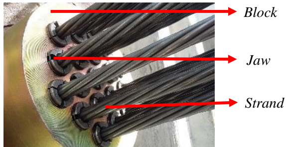
Sumber: Dokumen Pribadi Gambar 4. 72 Block dan Jaw Setelah Dipasang
