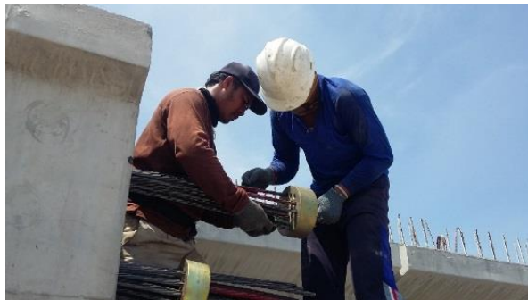
Sumber: Dokumen Pribadi Gambar 4. 70 Pemasangan Block
