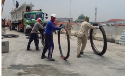
Gambar 4. 64 Pemindahan Kawat Strand Ke Tempat Install Strand Balok
