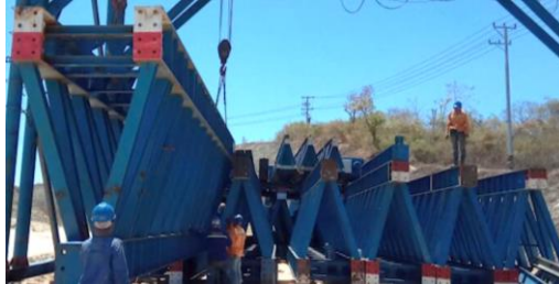
Gambar 4. 35 Kerangka Launcher Sebelum Dirakit
