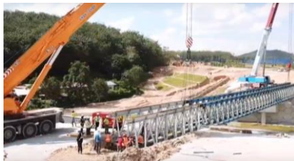
Gambar 4. 42 Pemasangan Launcher
