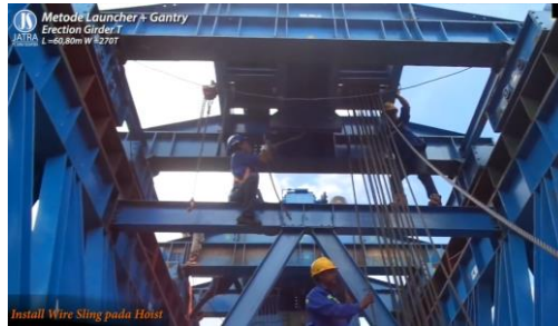
Gambar 4. 37 Install Wire Sling pada Hoist
