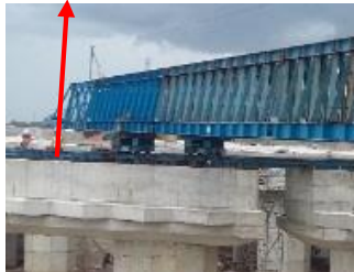
Sumber: Dokumen Pribadi Gambar 4. 28 Rel Geser Pada Pier 1
