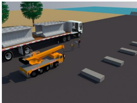
Gambar 4. 48 Proses Supply Girder Dilakukan Secara Segmental
