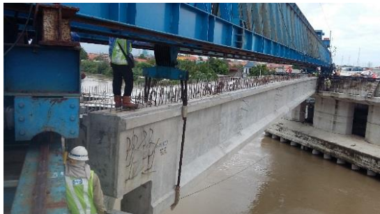
Gambar 4. 101 Proses Penurunan Girder
