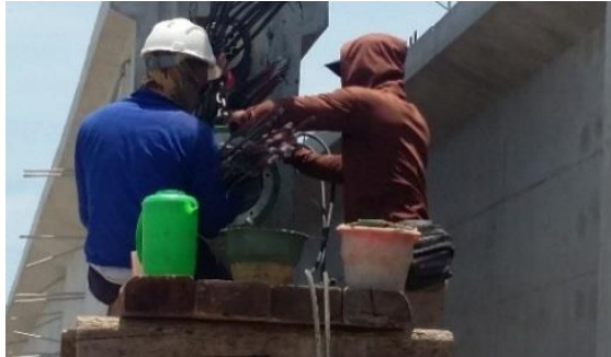
Gambar 4. 75 Pemasangan Stressing Jack
