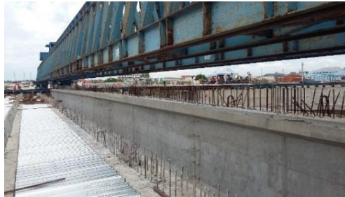
Gambar 4. 100 Balok Girder Mulai Turun
