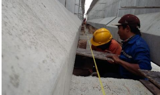
Gambar 4. 58 Setting Levelling Horizontal Balok Menggunakan Dongkrak Hidrolik
