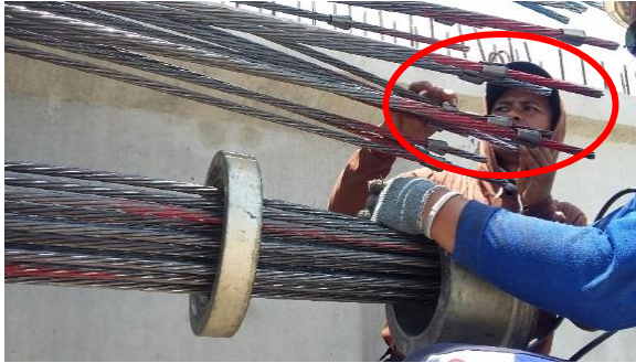
Sumber: Dokumen Pribadi Gambar 4. 71 Pemasangan Jaw
