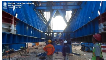
Gambar 4. 38 Pengangkatan Wire Sling Ke Alat Launcher
