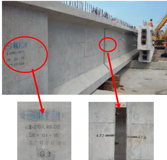
Gambar 4. 52 Perletakan Balok Sesuai Nomor Urut Balok dan Nomor Urut Segmen Balok
