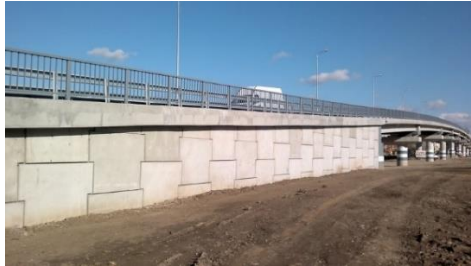
Gambar 2.13 Aplikasi tembok freyssisol pada oprit (Sumber: Terre-Armee, 2017)
