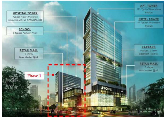
Gambar 1. 2 Pekerjaan proyek “ Gubeng Mixed-Use Development ” masih dalam Phase / Tahap 1 Sumber : Data Proyek
