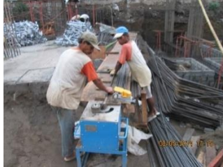
Gambar 4. 6 Fabrikasi Tulangan Kolom di Workshop Besi
