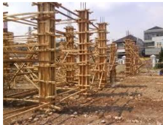
Gambar 4. 8 Bekisting Kolom Siap Cor (Sumber: https://andykasipil.blogspot.com/2011/12/galeri-foto-pada-proyek.html )
