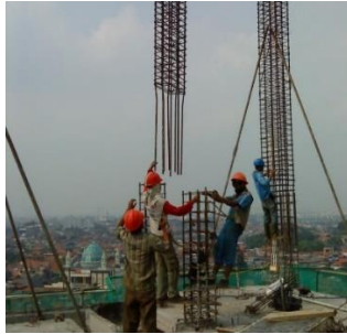
Gambar 4. 7 Instalasi Tulangan Kolom
