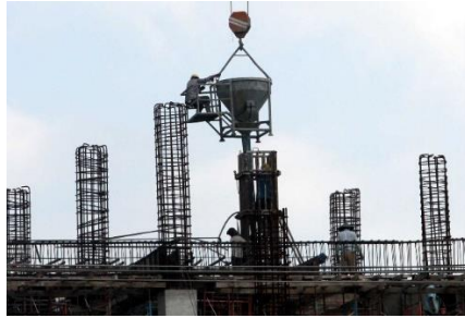
Gambar 4. 9 pengecoran Kolom
