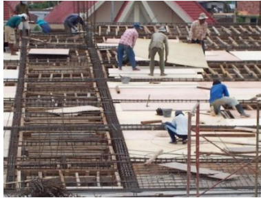
Gambar 4. 11 Pemasangan Besi Balok dan Plat Lantai (Sumber: https://proyeksipil.blogspot.com/2014/11/cara-dan-teknis-kerja-memasang-besi.html )
