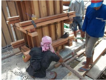
Gambar 5. 1. Mengecek Kelurusan Bekisting Kolom (Sumber: https://andykasipil.blogspot.com/2011/12/galeri-foto-pada-proyek.html )
