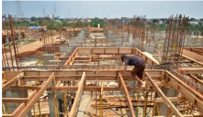
Gambar 4. 10 Persiapan Bekisting Balok dan Plat (Sumber: http://jagobangunan.com/article/read/lakukan-6-cara-ini-untuk-membuat-bekisting-kokoh-dan-anti-ambrol )
