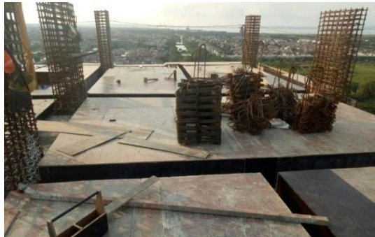
Gambar 4.3 Foto Pekerjaan Bekisting Pelat
