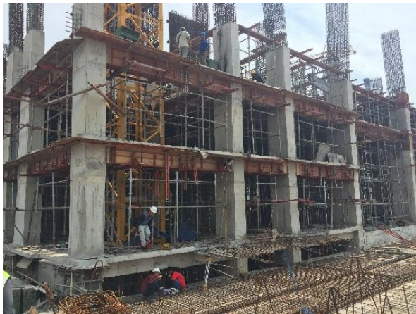
Gambar 4.4 Foto pemasangan penulangan Kolom
