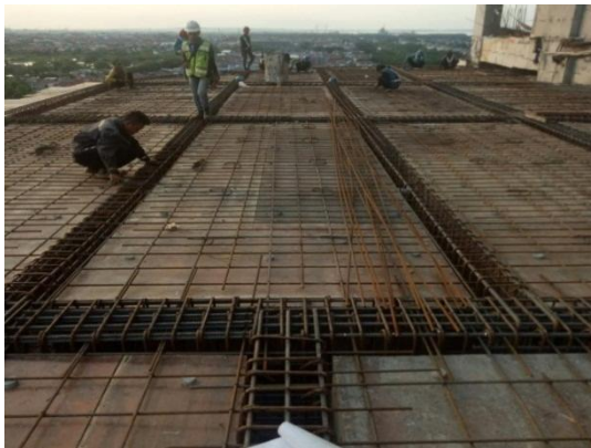
Gambar 4.6 Foto Pemasangan Penulangan Pelat
