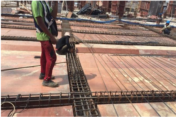
Gambar 4.5 Foto pemasangan penulangan Balok
