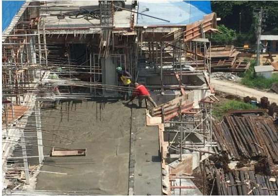
Gambar 4.9 Foto pekerjaan pengecoran pelat
