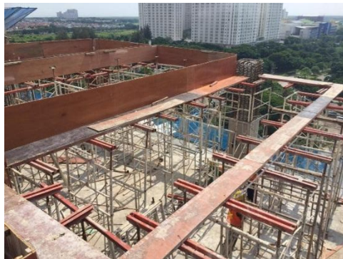
Gambar 4.2 Foto Pekerjaan Pemasangan Bekisting Balok
