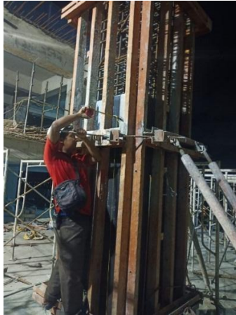
Gambar 4.1 Foto Pekerjaan Bekisting Kolom
