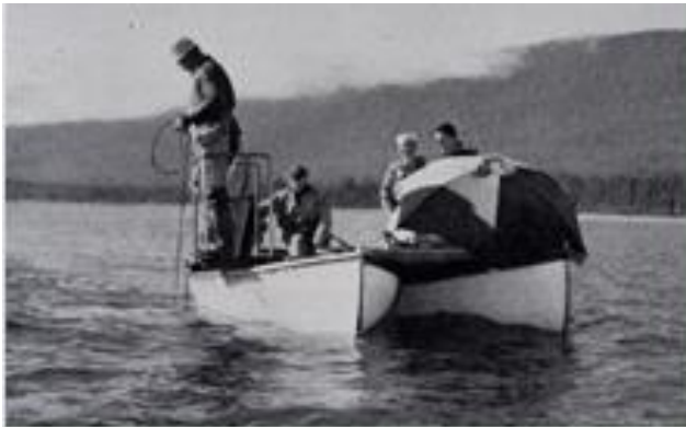
Gambar 2.6 Pengukuran Kedalaman Metode Mekanik (NOAA 2017)
