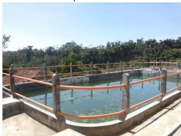
Gambar 2.8 Kolam Maturasi pada IPLT Kota Batu
