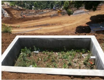
Gambar 2.10 Kolam Wetland pada IPLT Kota Batu Sumber: UPTD PALD Kota Batu, 2016
