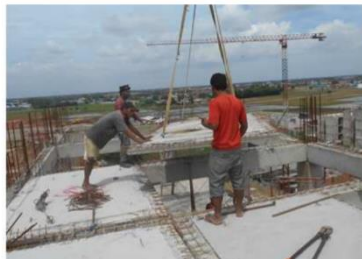
Gambar 6.11 Pengangkatan dan Pemasangan Komponen Precast
