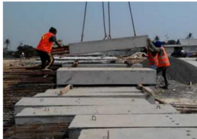
Gambar 6.10 Penumpukan Komponen Precast
