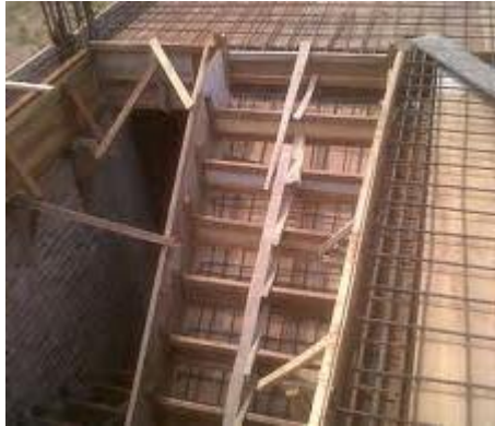
Gambar 6.12 Bekisting Tangga
