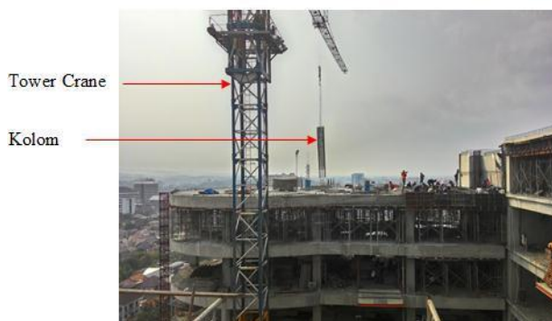
Gambar 6.5 Pengangkatan Tulangan menggunakan Tower Crane
