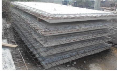
Gambar 6. 9 penyimpanan Komponen Precast
