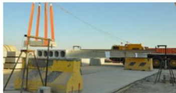
Gambar 2.2 Tampak samping pengecoran pada HCS (Sumber: Islam M. Ezz El-Arab, 2017)
