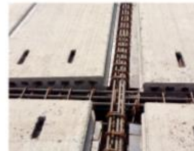
Peletakan HCS di tumpukan samping
