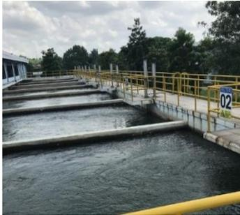
Gambar 2.6 Unit *Filter* di IPAM Karangpilang III
