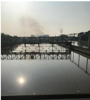
Gambar 2.3 Unit Prasedimentasi di IPAM Karangpilang III
