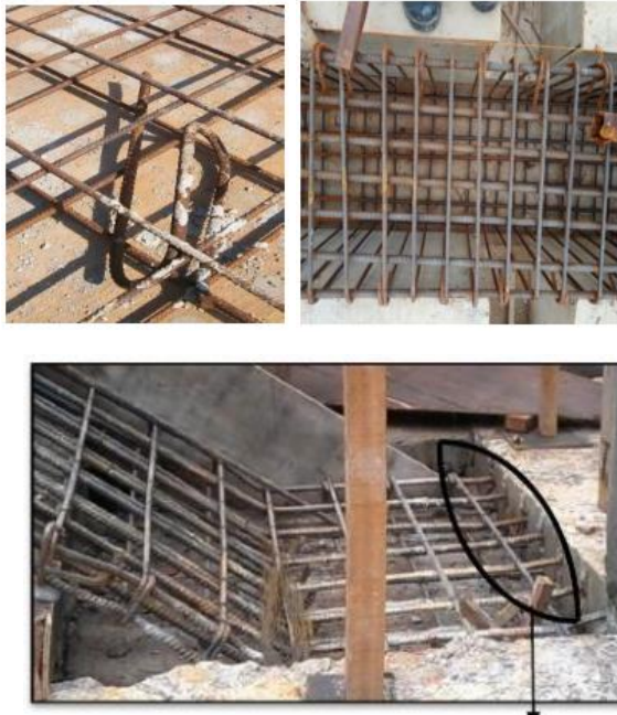
Gambar 5. 11 Pemasangan Tulangan Balok, Plat, dan Tangga (Sumber : Dokumen Pribadi)
