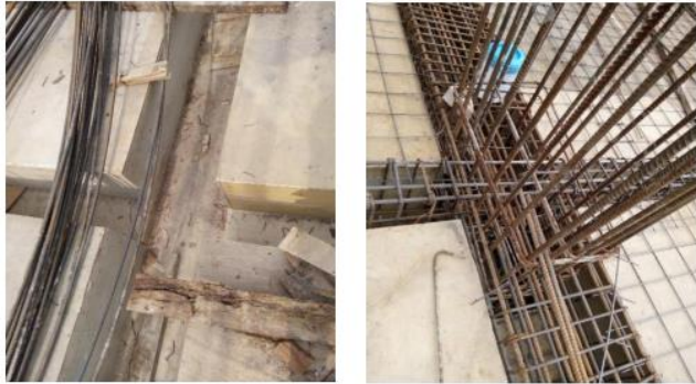
Gambar 5. 3 Pembesian Kolom (Sumber : Dokumen Pribadi)
