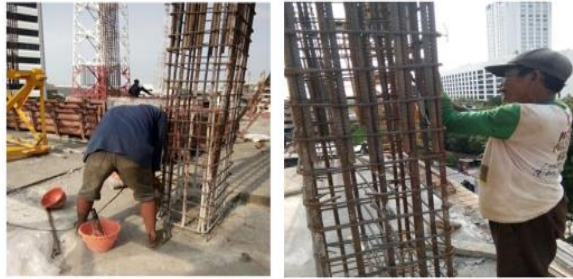
Gambar 5. 4 Pemasangan Tulangan Kolom (Sumber : Dokumen Pribadi)
