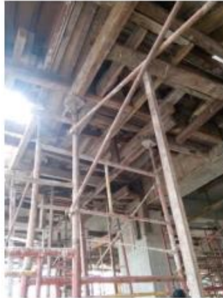
Gambar 5. 10 Pemasangan Alas untuk Bekisting Plat (Sumber : Dokumen Pribadi)
