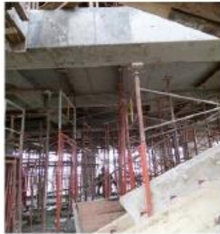
Gambar 2. 13 Scaffolding (Sumber : Dokumen Pribadi)
