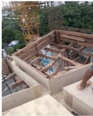
Gambar 5. 9 Pemasangan Bekisting Balok dan Plat
