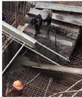
Gambar 2. 11 Concrete Vibrator (Sumber : Dokumen Pribadi)
