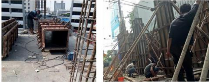
Gambar 5. 5 Pemasangan Bekisting Kolom (Sumber : Dokumen Pribadi)
