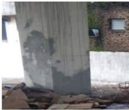
Gambar 5. 6 Hasil Kolom yang Telah dibongkar (Sumber : Dokumen Pribadi)
