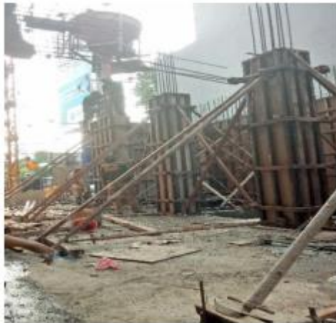
Gambar 5. 7 Pengecoran Kolom (Sumber : Dokumen Pribadi)
