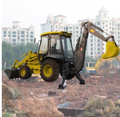
Gambar 2. 10 excavator untuk Galian
