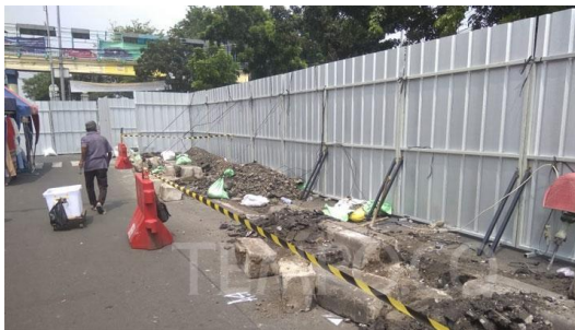
Gambar 4. 2 Pemagaran Sekitar Lokasi Proyek
