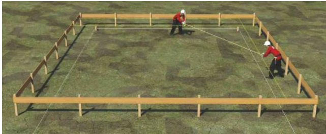
Gambar 4. 3Pemasangan Bouwplank
