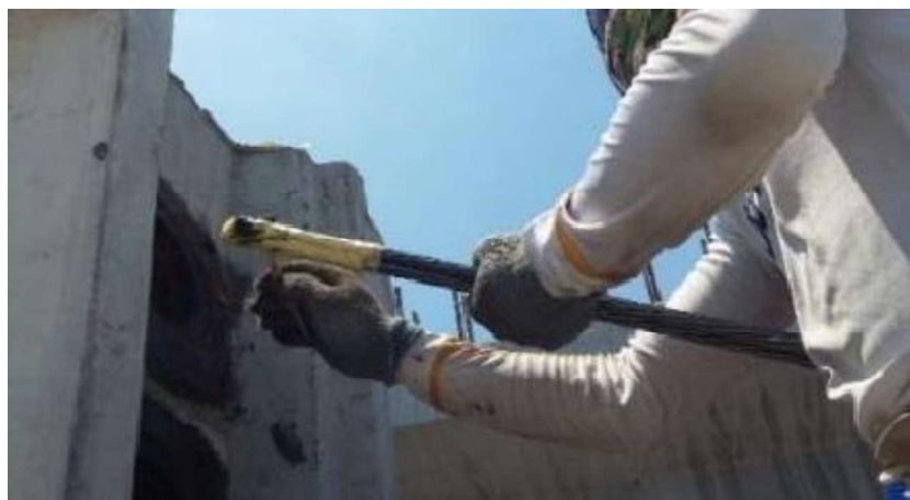
Gambar 4.19 pemberian solasi dan stempet sebagai pelicin install strand
