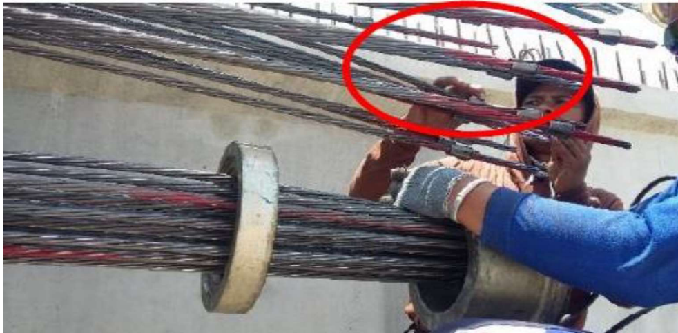
Gambar 4.24 Pemasangan jaw
