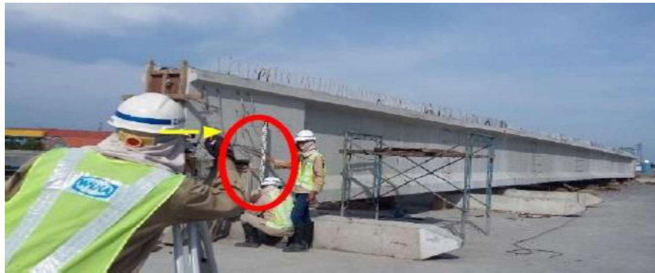
Gambar 4.38 kontrol chamber 1 pada tepi balok
