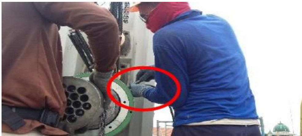
Gambar 4.27 Pemasangan stressing jack
