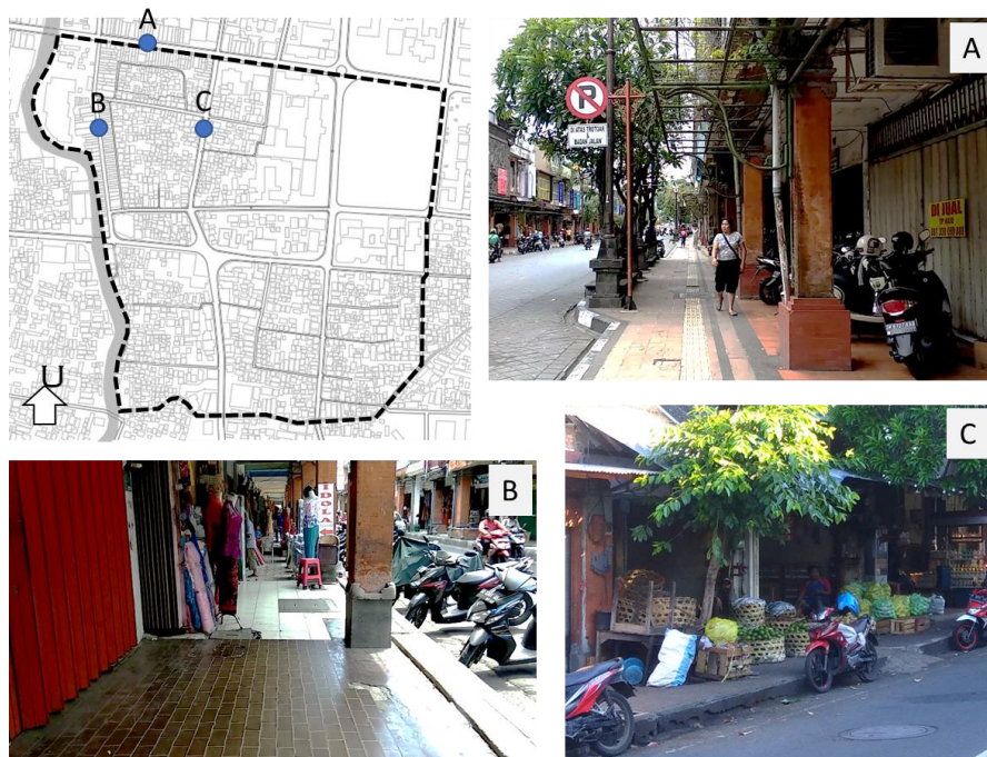
Gambar 4.27. Kondisi Trotoar Jalan Gajah Mada (A), Jalan Sulawesi (B) dan Jalan Sumatera (C) (Survei, 2019)
