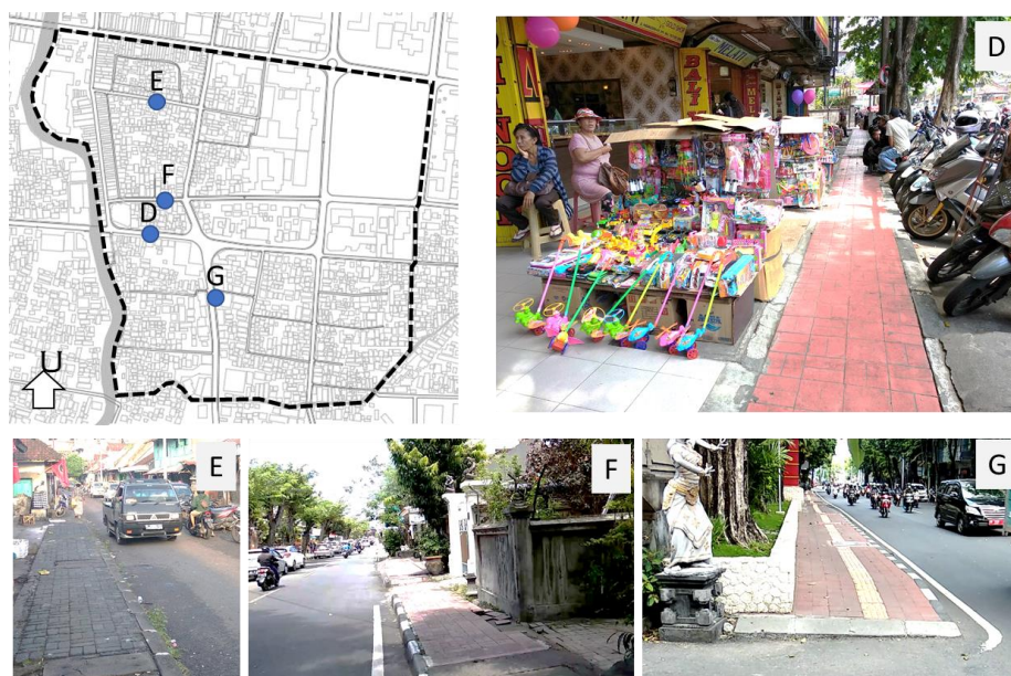
Gambar 4.28. Kondisi Trotoar Jalan Hasanuddin (D), Jalan Ternate (E), Jalan Kalimantan (F) dan Jalan Diponegoro (G) (Survei, 2019)
