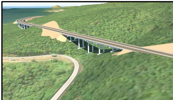
Gambar 4.12 Jembatan pada STA 44+055.75 – 44+258.085
