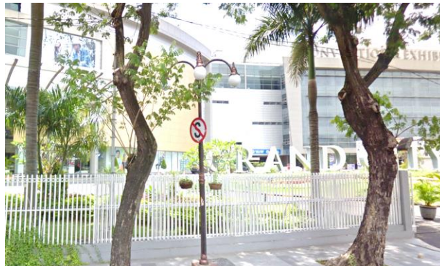
Gambar 4.37 Penggunaan pagar sebagai pembatas fisik zona E (sumber: peneliti, 2018)
