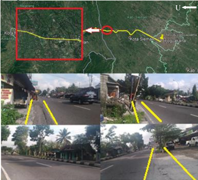
Gambar 4. 7 Kondisi Terkini STA 15+350-17+850
