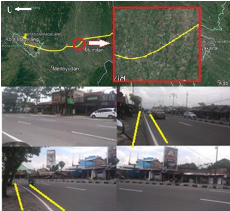
Gambar 4. 10 Kondisi Terkini STA 27+350-29+850
