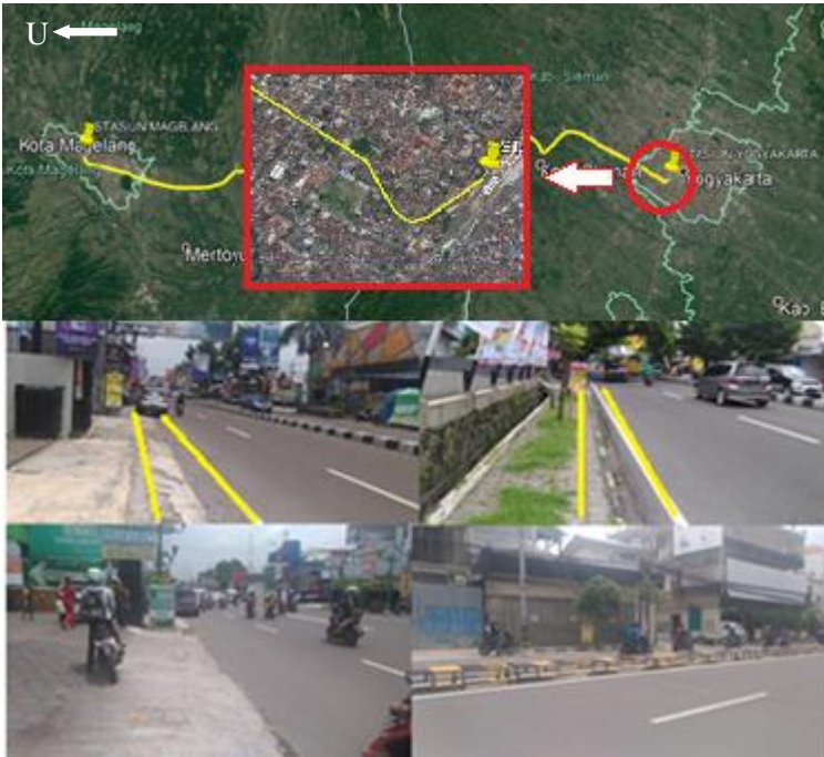
Gambar 4. 2 Kondisi Terkini STA 0+00-7+350
