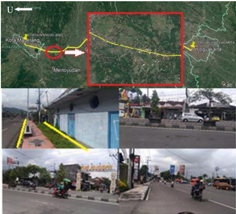
Gambar 4. 14 Kondisi Terkini STA 39+350-40+850
