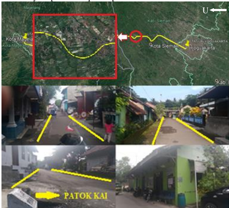
Gambar 4. 5 Kondisi Terkini STA 13+350-14+350
