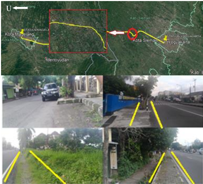
Gambar 4. 4 Kondisi Terkini STA 10+850-13+350
