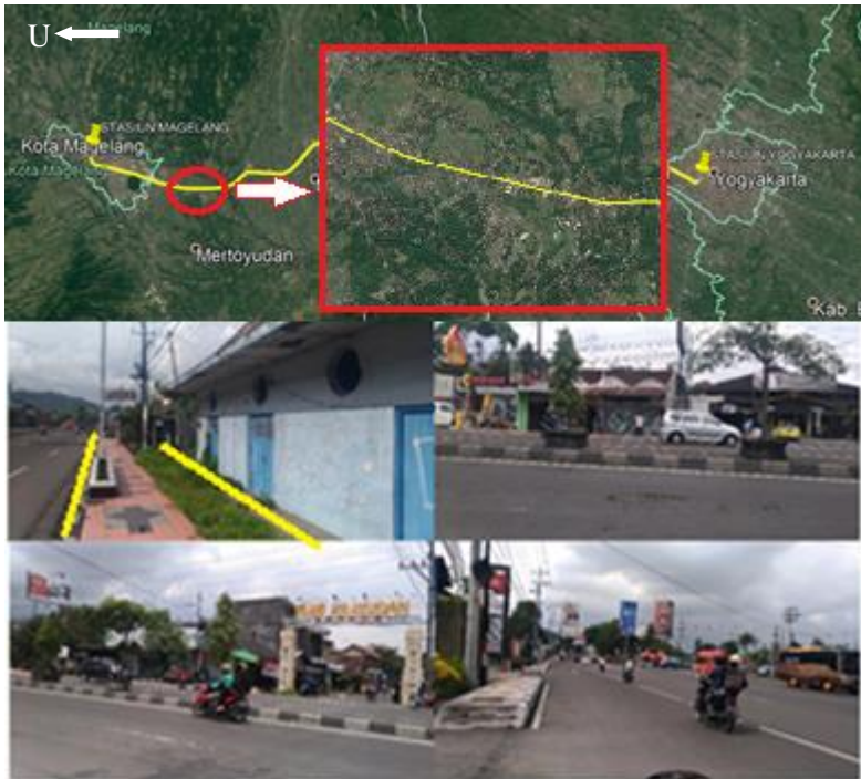
Gambar 4. 13 Kondisi Terkini STA 37+850-39+350
