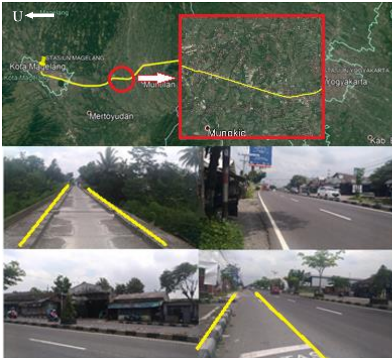
Gambar 4. 11 Kondisi Terkini STA 29+850-31+350
