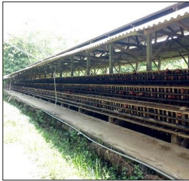
Gambar 4. 16 Bangunan Kandang di Kecamatan Talun
