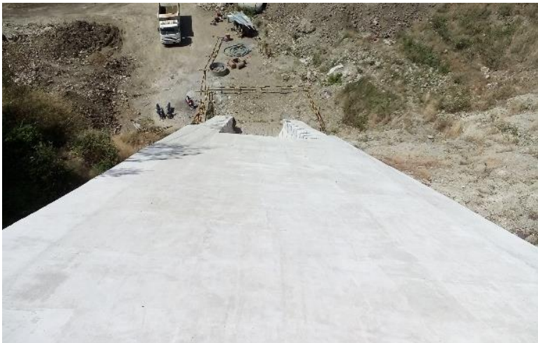
Gambar 1.4 Tampak Atas Intake (Sumber : Penulis, 2018)
