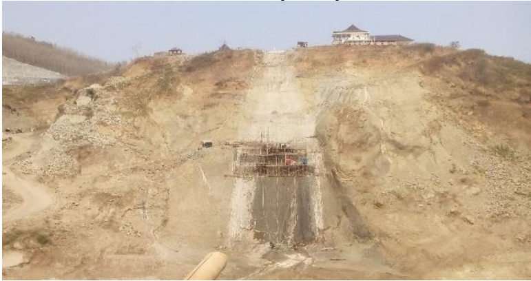
Gambar 1.3 Tampak Samping Bendungan Yang Belum Diurug (Sumber : Penulis, 2018)
