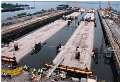
Gambar 5.27 Proses pembanjiran segmen sebelum transportasi
