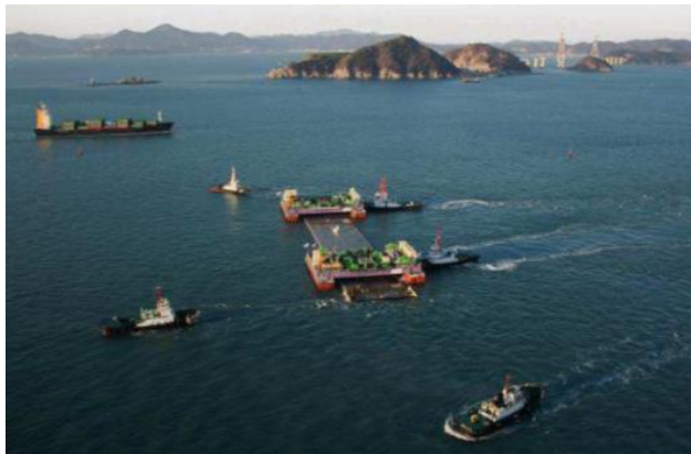
Gambar 2.6 Proses pengapungan elemen immersed tunnel
