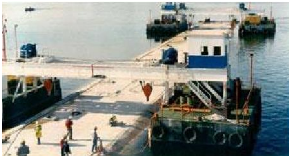
Gambar 5.29 Proses penenggelaman segmen terowongan
