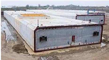
Gambar 5.26 Segmen terowongan setelah dipasang bulkheads Sumber : (Wikipedia.com)
