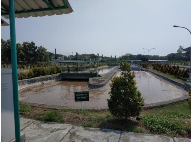
**Gambar 4. 4 Oxidation ditch**
