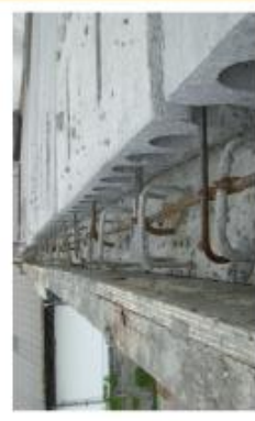
2. Di atas struktur beton
